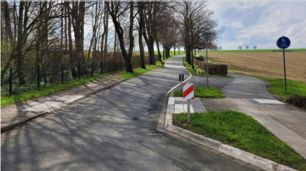
Beidseitige Fahrbahnverengung Volbrexener Str. (K 35) in Weiberg
